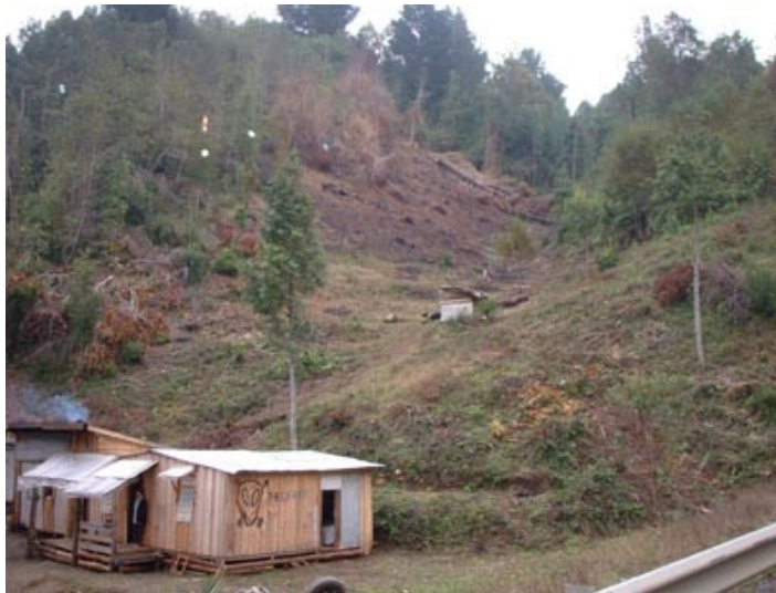
Foto 7. Situación inminente riesgo de remoción en masa
